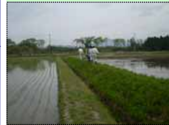
農地の機能診断等により水路溝畔の漏水状況を把握します。
