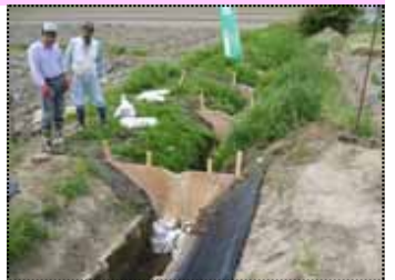
堰上げ式の水田魚道は、農業濁水の流出防止にも役立ちます。
