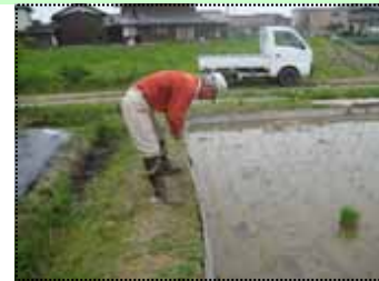
畦シートの設置により漏水を防止します。
