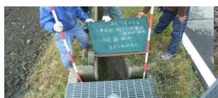
↑ 用水路の点検
