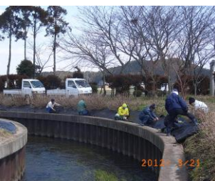
↑ 防草シート貼り
