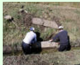
排水路の補修
