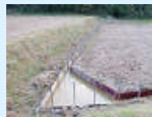
水田内水路の設置
