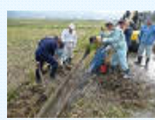
水路法面の初期補修
