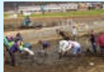
浄化池の泥上げ
