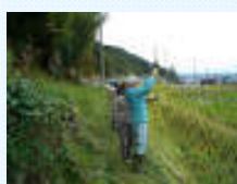
鳥獣害防護柵の補修・設置
