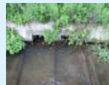
魚巢ブロックの設置
