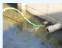
暗渠施設の清掃
