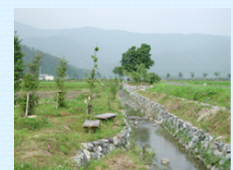
石積水路の設置
