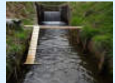
水路からの脱出施設の設置
