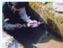
水路のひび割れ補修
