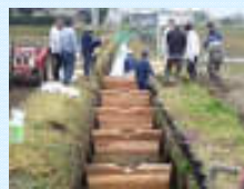
水路魚道の設置(堰上式)
