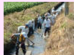
水路の泥上げ
