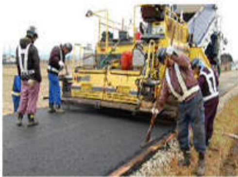
アスファルト舗装状況
