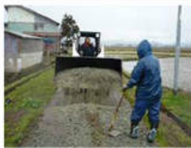
砂利の敷き均し
