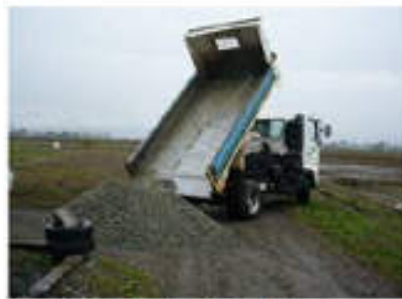
砂利の荷下ろし
