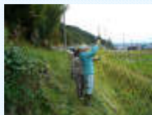
鳥獣害防護柵の補修・設置
