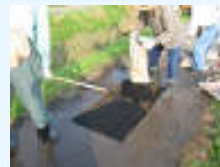
農道の部分補修
