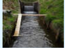
水路からの脱出施設の設置
