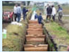
水路魚道の設置(堰上式)
