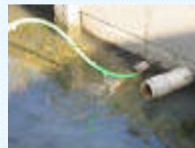
暗渠施設の清掃
