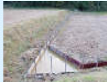
水田内水路の設置
