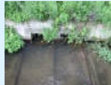
魚巢ブロックの設置
