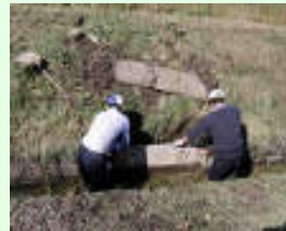
排水路の補修
