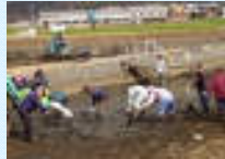
浄化池の泥上げ
