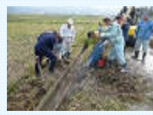
水路法面の初期補修
