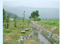
石積水路の設置
