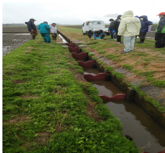
道山寺・今宮排水路（堰板の設置）
