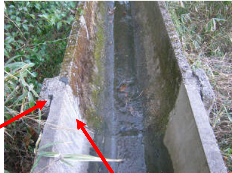
目地モルタルの割れ
