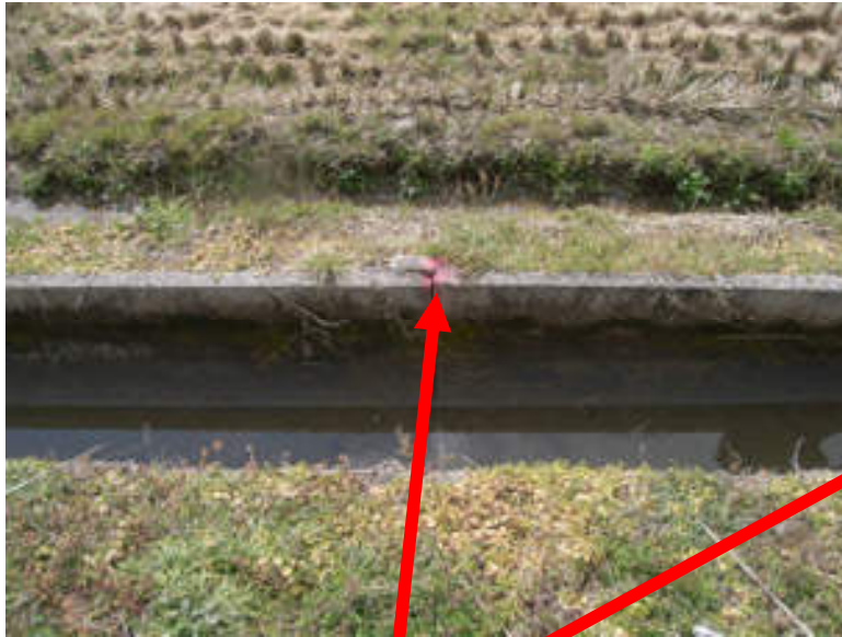
パッキンの劣化
