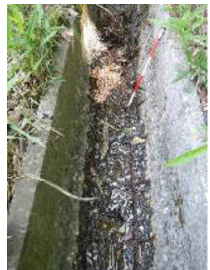
長寿命化事業取組前の水路
