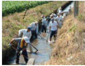
水路の泥上げ
