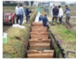
水路魚道の設置（堰上げ式）
