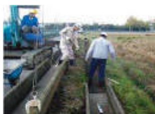
用水路の補修・更新
