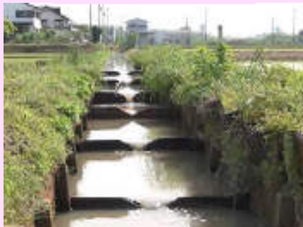
⑨堰上式魚道
