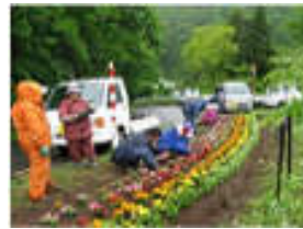
農道法面への植栽
