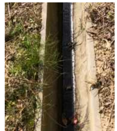
【用水路の外注施工】
