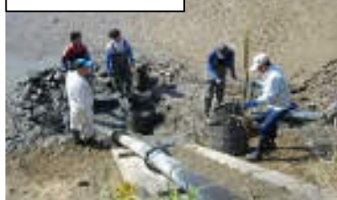
ため池の浚渫
