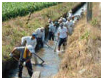
水路の泥上げ
