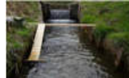
水路からの脱出施設設置
