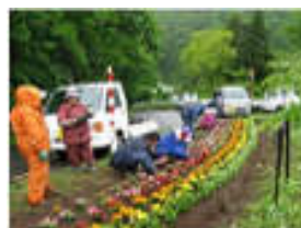
農道法面への植栽
