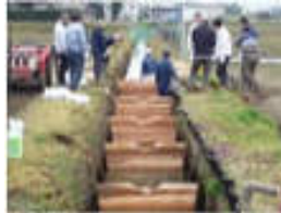
水路魚道の設置（堰上げ式）
