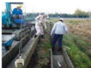
用水路の補修・更新
