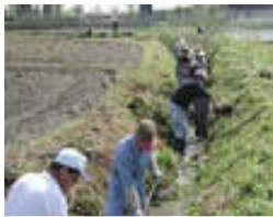
水路の泥上げ
