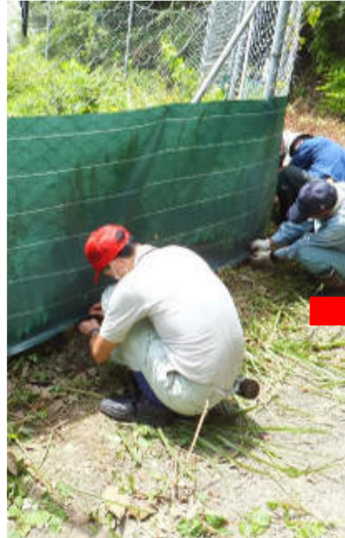
穴を直して防草シートで目隠し
