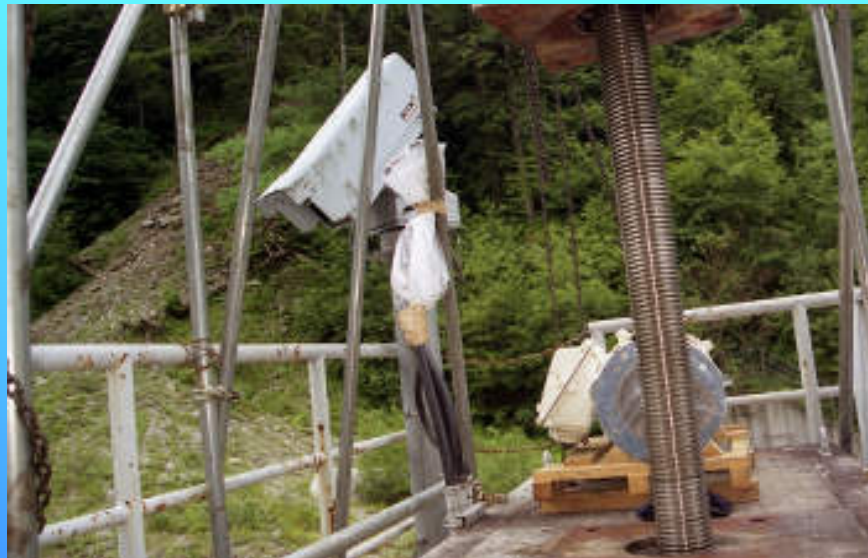
清掃点検完了
