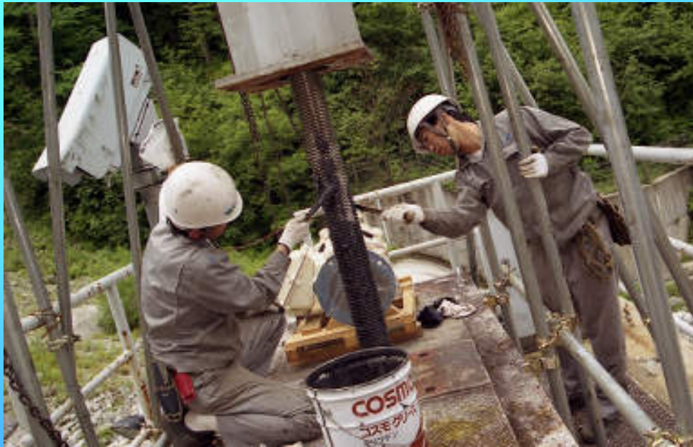
点検完了後グリス塗布
