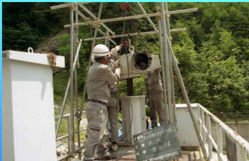
バルブコントロール 取外し
