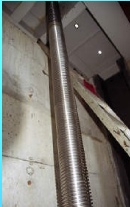
清掃点検完了
