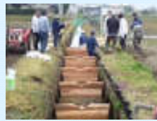
水路魚道の設置（堰上式）
