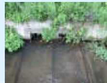
魚巣ブロックの設置
