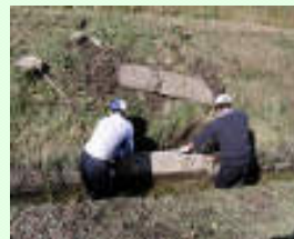
排水路の補修
