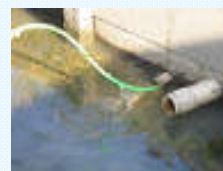
暗渠施設の清掃
