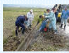
水路法面の初期補修
