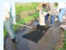
農道の部分補修
