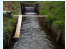
水路からの脱出施設の設置
