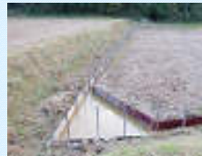
水田内水路の設置
