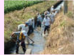
水路の泥上げ
