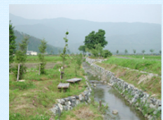
石積水路の設置
