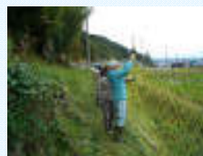
鳥獣害防護柵の補修・設置
