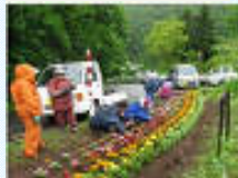
道路法面への植栽
