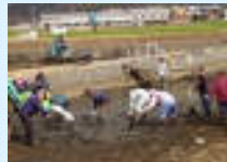
浄化池の泥上げ
