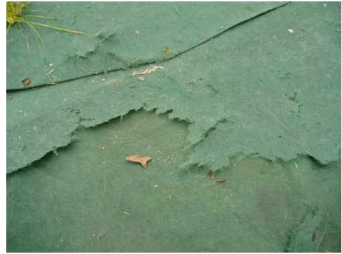
紫外線等の劣化により、シートが破損した例
