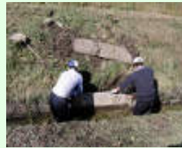
排水路の補修
