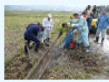
水路法面の初期補修
