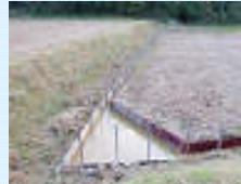
水田内水路の設置
