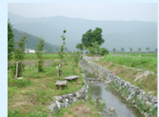
石積水路の設置
