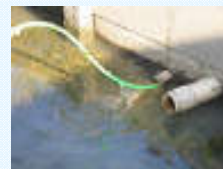
暗渠施設の清掃
