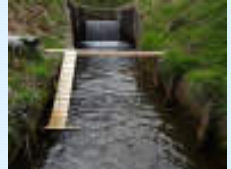
水路からの脱出施設の設置
