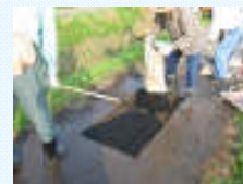
農道の部分補修
