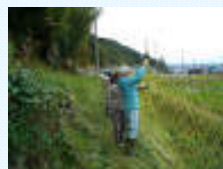
鳥獣害防護柵の補修・設置
