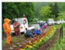
道路法面への植栽
