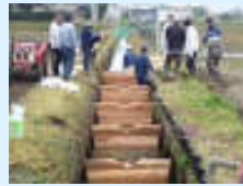
水路魚道の設置（堰上式）
