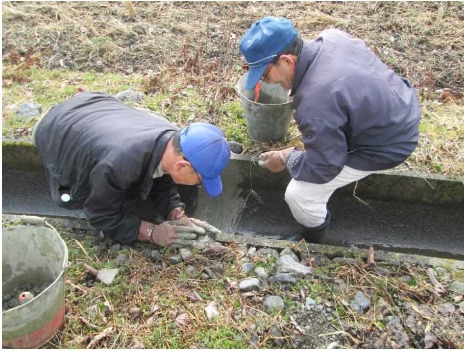
水路目地補修作業
