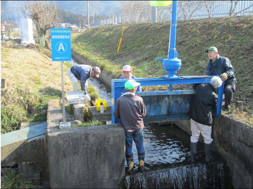
取水ゲート施設の の修繕作業
