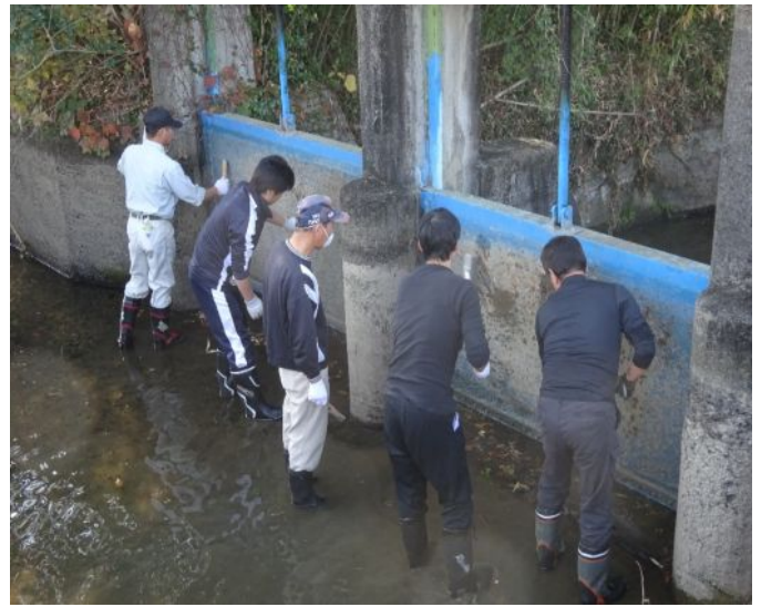
水門ゲートの塗装作業
