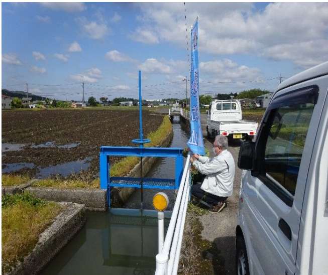
濁水防止のぼり旗の設置
