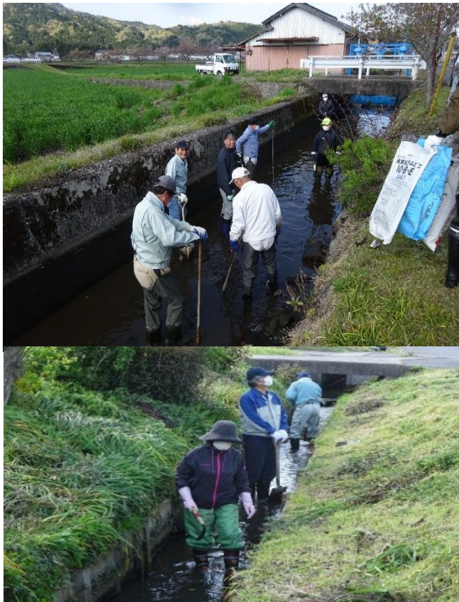
水路の泥上げ作業
