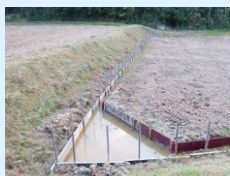
水田内水路の設置
