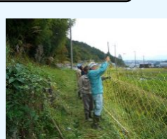
鳥獣害防護柵の補修・設置
