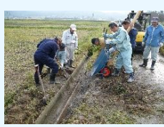
水路法面の初期補修
