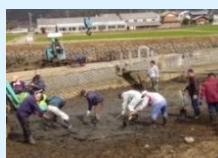
浄化池の泥上げ
