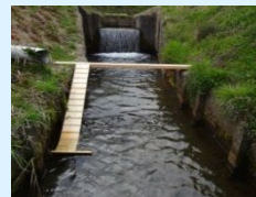
水路からの脱出施設の設置
