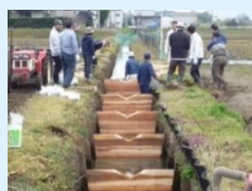
水路魚道の設置(堰上式)
