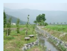
石積水路の設置
