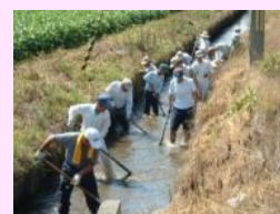
水路の泥上げ
