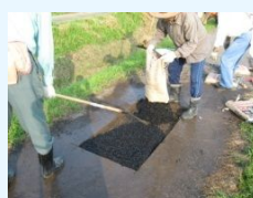
農道の部分補修
