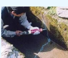
水路のひび割れ補修
