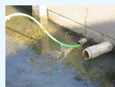
暗渠施設の清掃
