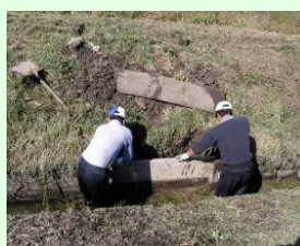
排水路の補修
