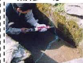
水路のひび割れ補修
