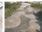
農道の窪みの補修
