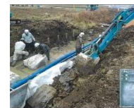
排水路の更新・ 魚巢ブロックの設置
