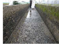
現場打ち コンクリート水路
