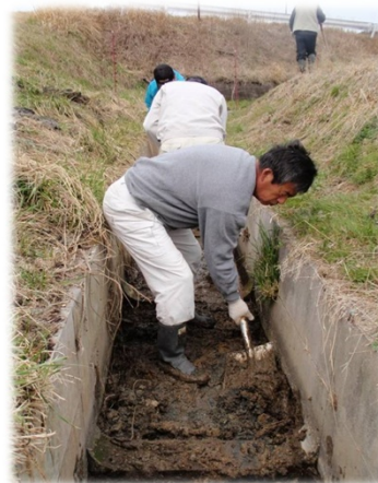
排水路の泥上げ中
