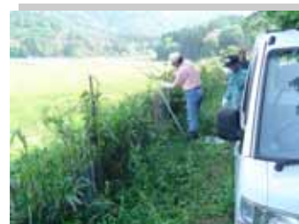
鳥獣害柵の補修（近江八幡市島）
