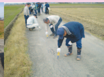
ひび割れの補修作業
