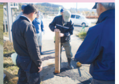
常温合材による穴の補修作業
