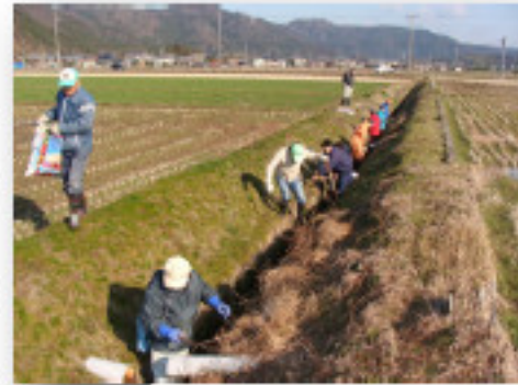
■ 水路の泥上げ ■
