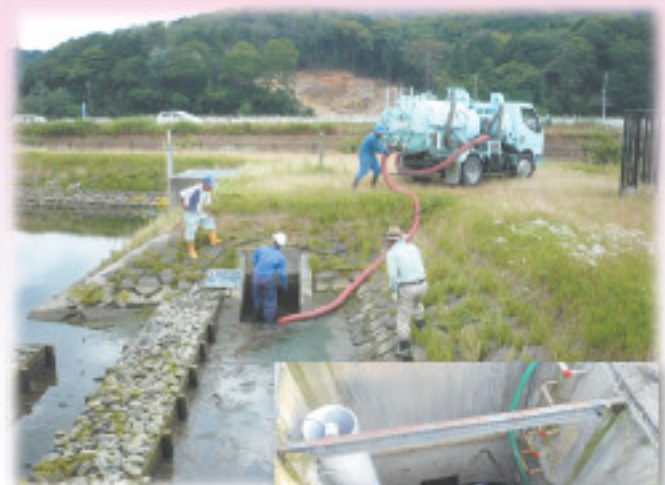
揚水場の清掃
