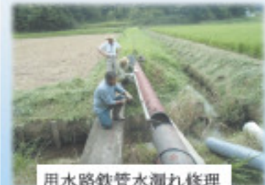
用水路鉄管水漏れ修理
