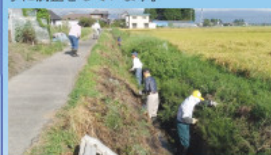
水路清掃の様子
