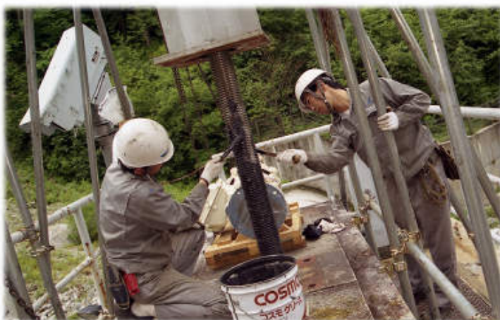
点検完了後グリス塗布
