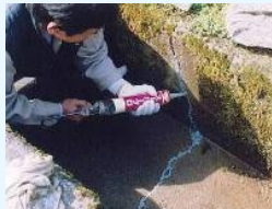
水路のひび割れ補修
