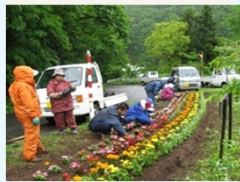
道路法面への植栽
