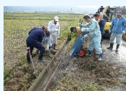
水路法面の初期補修
