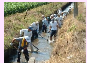
水路の泥上げ
