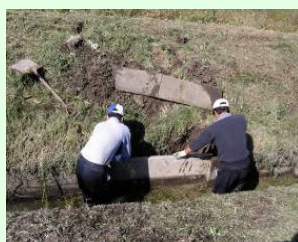
排水路の補修
