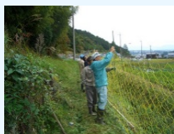
鳥獣害防護柵の補修・設置
