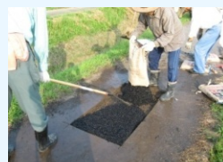
農道の部分補修
