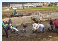
浄化池の泥上げ
