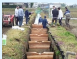
水路魚道の設置(堰上式)
