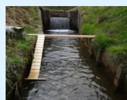
水路からの脱出施設の設置
