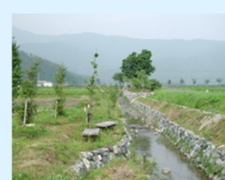
石積水路の設置
