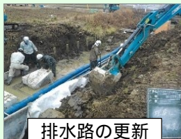
排水路の更新
