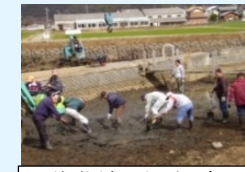
浄化池の泥上げ
