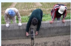
施設の機能診断
