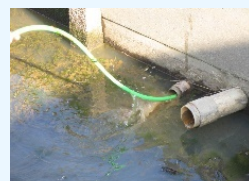
暗渠施設の清掃
