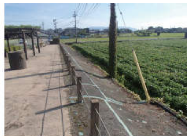
敷設後12年経過(福井県あわら市)
