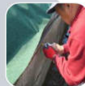
端部接着処理
