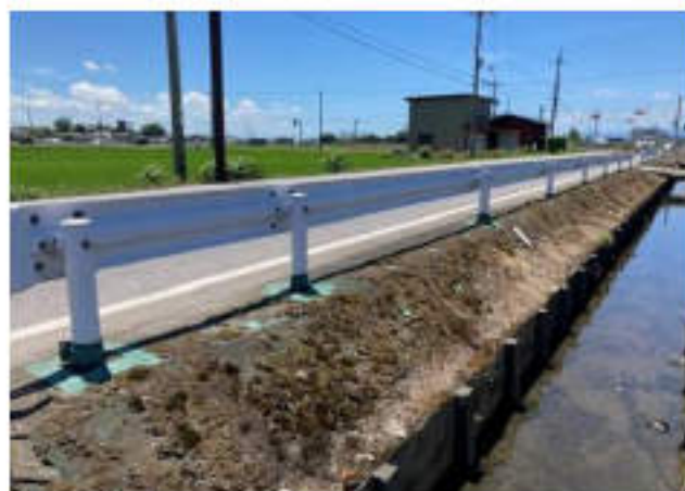
敷設後12年経過(長浜市)
